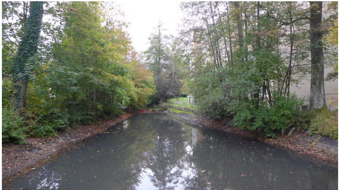
Abb. 7: Blick vom Abschlussdamm in Richtung Einlauf
